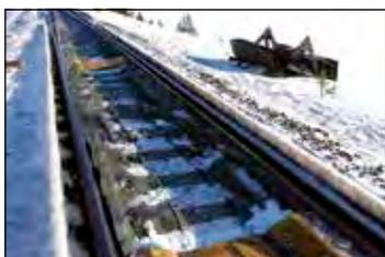
Speziellösungen für den Schienenverkehr: Schneeschutzsysteme für Weichen.
